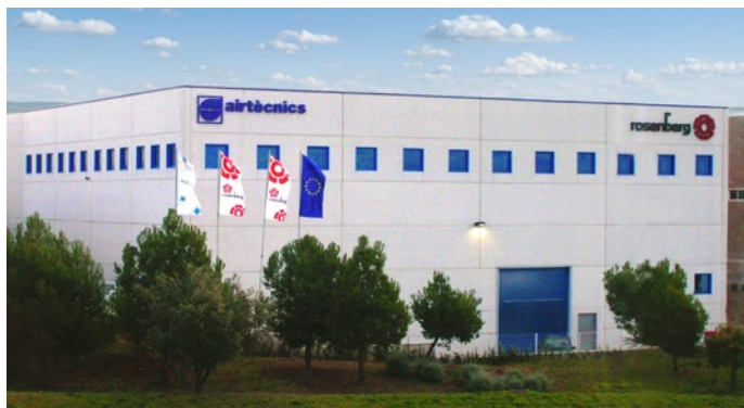
Seu d'Airtècnics a Castellar del Vallès (Barcelona)
