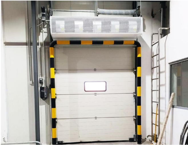
Fly KL Instal·lació en porta de servei d'una fàbrica de pa
