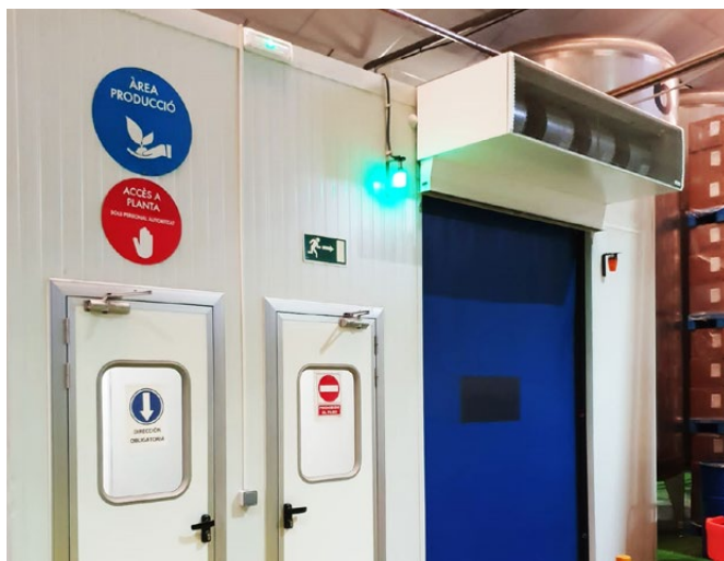
Fly KXL Instal·lació en una fàbrica de producció de mel
