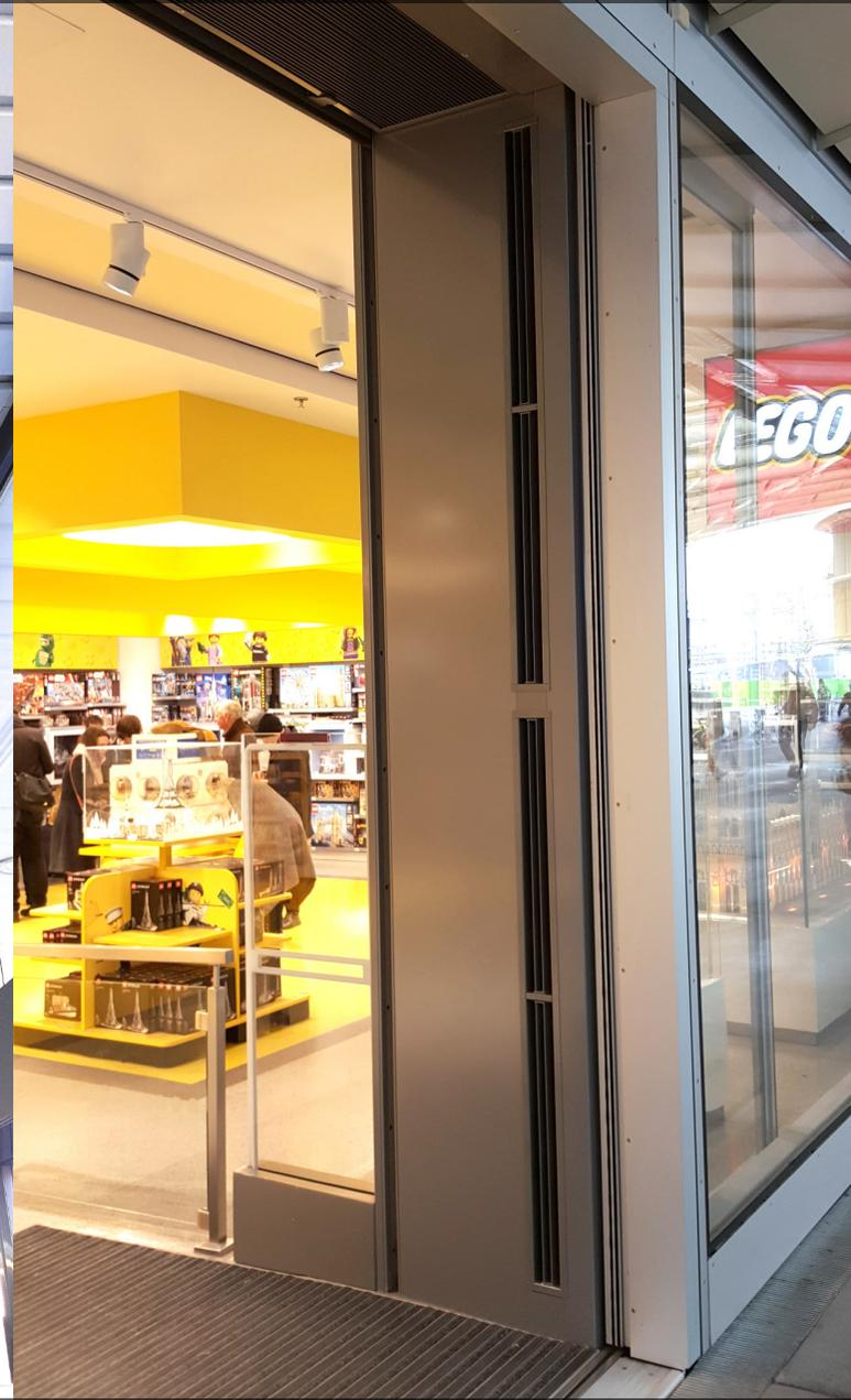
Cortina de aire INVISAIR con acabado RAL para instalación invisible en vertical al lado de la puerta.
