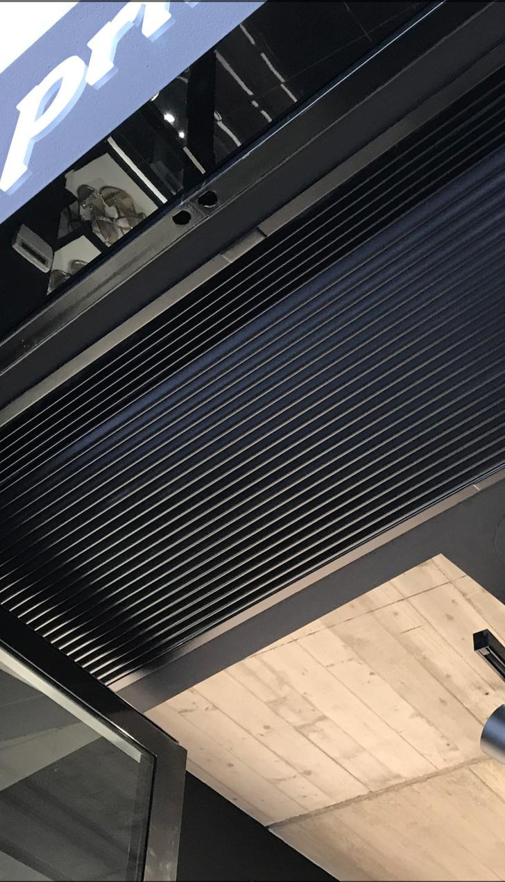
Cortina de aire DAM EMPOTRABLE con rejilla de absorción y descarga integrada y acabado RAL.
