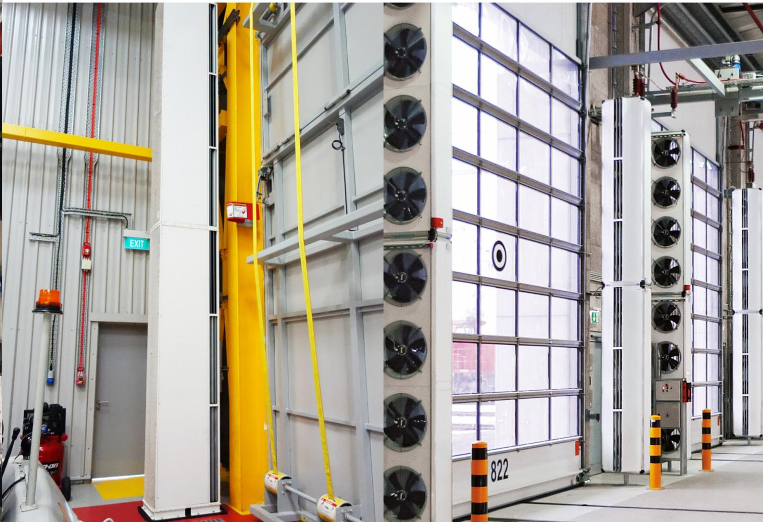
Las cortinas de aire WINDBOX BB, L y XL crean una barrera de aire eficaz a alta presión para puertas de hasta 8 metros de altura, reduciendo las pérdidas de energía. Instalación horizontal, vertical o empotrada.
