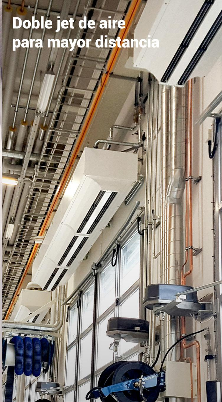
Cortinas de aire MAXWELL de alto rendimiento para instalaciones verticales u horizontales en grandes puertas industriales. Con el doble jet de aire de efecto coanda, se logran mayores distancias de forma más eficiente gracias a los módulos fácilmente acoplables.
