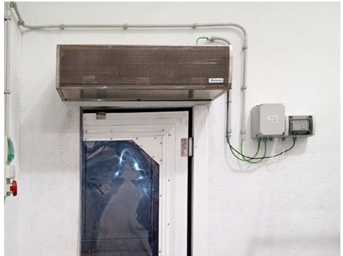
Fly K Instalación IP55 en la puerta de servicio de una fábrica
