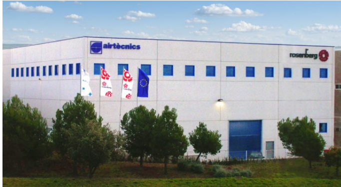
Sede de Airtècnics en Castellar del Vallès (Barcelona)
